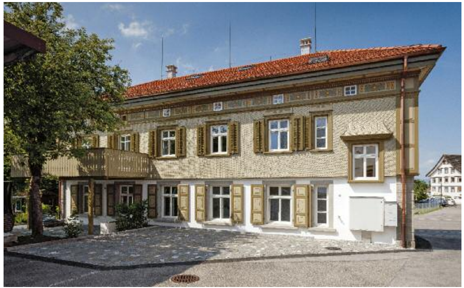
Die renovierte Rückfassade mit dem rekonstruierten Balkon; im Erdgeschoss die neu bemalten Fensterläden.
