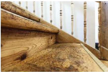
Unter Verkleidungen hervorgeholte Treppenstufen mit ihren Spuren der Zeit.
