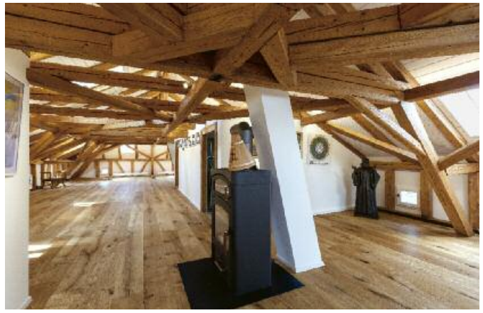
Der grosszügige, aber niedrige Dachboden mit dem traditionell abgezimmerten Dachstuhl wird zum Ausstellungsraum.
