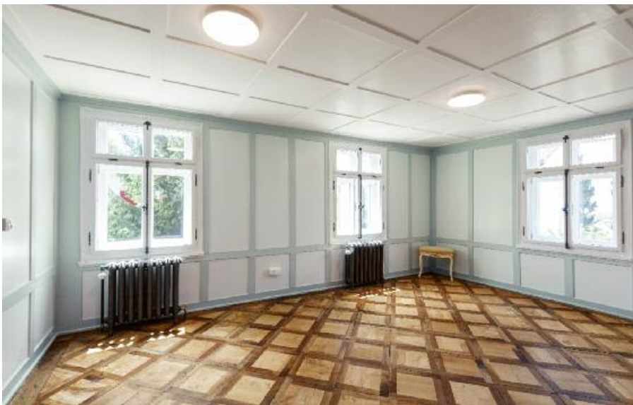
Stube im Obergeschoss mit restauriertem Tafelparkett, mit neuer, aber historisch passender Farbgebung und mit neuen Radiatoren im Jahrhundertwende-Stil.
